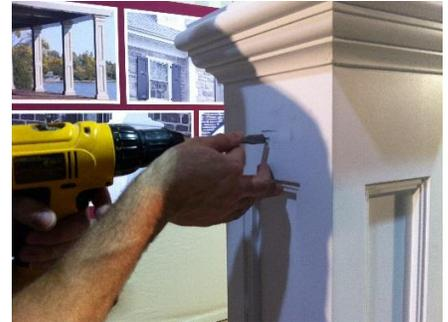
12. À l'aide d'une mèche de 5/8", percer au centre du trou tracé à l'étape 11.
