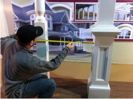
1. Après l'installation des colonnes, poteaux et poteaux de rampe, mesurer précisément la mesure la longueur de la rampe (partie du haut : main-courante, et partie du bas : lisse) entre les poteaux.
