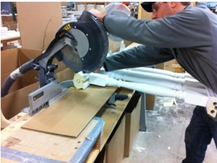
4. Couper la main-courante et la lisse à l'aide d'une scie à onglet ayant une lame de finition en utilisant les lignes tracées précédemment comme guide. Appliquer un carton sous la rampe pour protéger sa peinture des éraflures.
