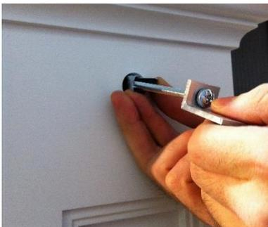
13. À l'aide des ancrages papillon à ressort fournis, fixer les supports de fixation du haut (pour main-courante) et du bas (pour lisse) sur chaque poteau, ou poteau et mur. S'assurer que les supports sont centres et droits.
