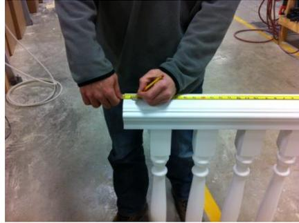
2. Reporter cette mesure sur la rampe et dessiner une ligne aux deux extrémités de la main-courant et de la lisse afin que les balustres soient centrés.
