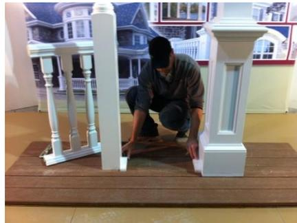
5. Placer 2 blocs de support à côté de chaque poteau et mettre la rampe au-dessus, entre les 2 poteaux, ou le mur et le poteau.
