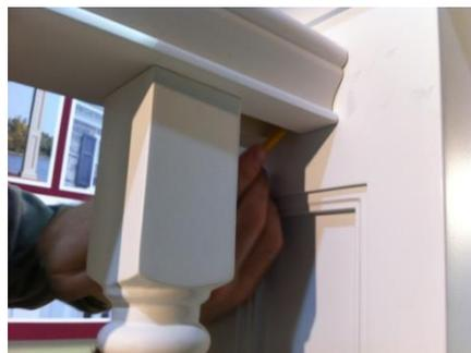
8. Tracer une ligne sur chaque poteau (ou mur et poteau) à chaque extrémité de la partie inférieure de la main-courante et de la lisse où les supports de fixation seront installés.
