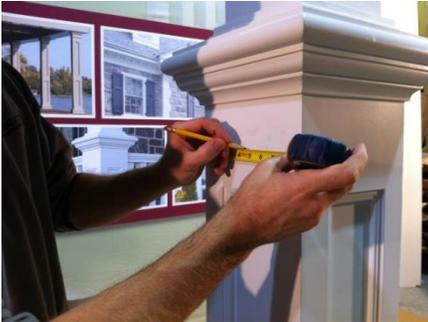
10. Pour chaque ligne tracée à l'étape 8, mesurer le centre de chaque poteau et tracer une ligne afin de bien centrer les supports de fixation.
