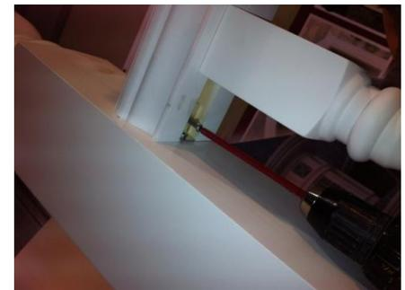
24. Fixer les deux extrémités des supports de fixation de la main-courante à l'aide des vis fournies.
