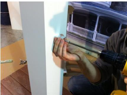
13. À l'aide des vis fournies, fixer les supports de fixation du haut (pour main-courante) et du bas (pour lisse) sur chaque poteau, ou poteau et mur. S'assurer que les supports sont centrés et droits.
