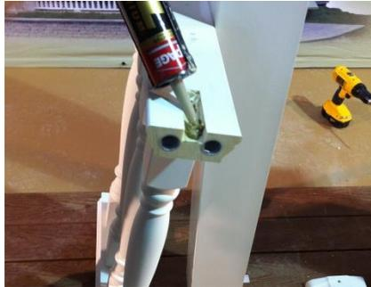
20. Appliquer une bille de ½" d'adhésif de construction à base d'uréthane à la partie inférieure de chaque extrémité de la main-courante et de la lisse, où les supports de fixation seront fixés.
