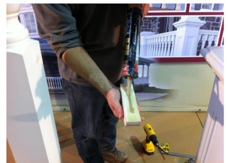
18. Appliquer de l'adhésif de construction à base d'uréthane (PL Premium) sous le bloc de support.
