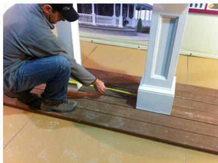
17. **Installation du bloc de support de la rampe**: mesurer et tracer une ligne au centre entre chaque poteau où le bloc de support sera installé.
