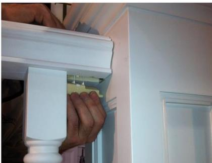
25. Installer les blocs de fixation à chaque extrémité de la main-courante et de la lisse.
