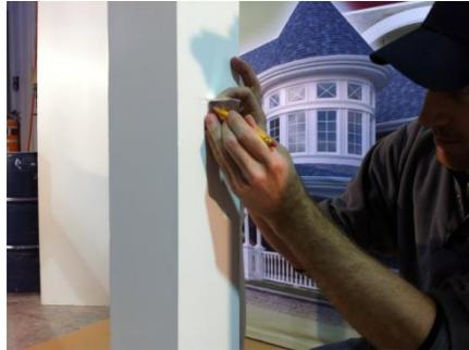
11. Placer le support de fixation sous les lignes tracées à l'étape 8 et tracer le trou du support sur chaque poteau, ou mur et poteau. S'assurer que le support de fixation est centré sur le poteau.
