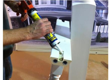
21. Appliquer une ligne de calfeutrant de silicone à la partie inférieure de chaque extrémité de la main-courante et de la lisse, où les blocs de fixation seront installés.
