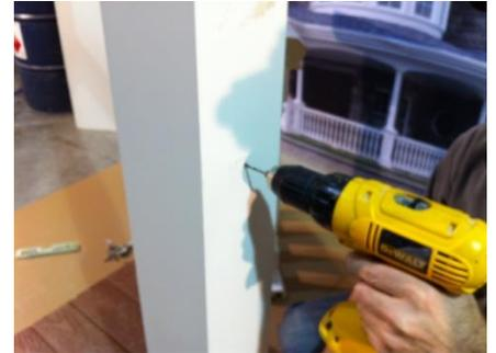
12. À l'aide d'une mèche de 1/8", percer le trou tracé à l'étape 11.
