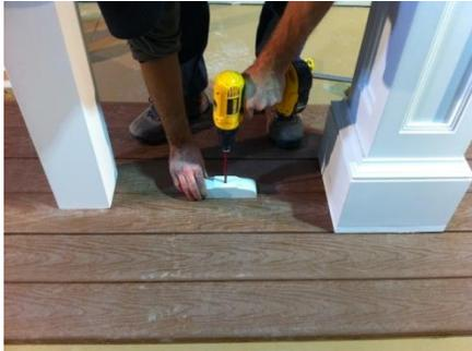
19. Fixer le bloc de support avec une vis. S'assurer que le bloc est centré entre chaque poteau, ou mur et poteau.
