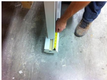
14. **Coupe des blocs de fixation** : Pour chaque rampe, 4 blocs sont fournis pour cacher les supports de fixation. Mesurer chaque la partie inférieure de chaque extrémité de la main-courante et de la lisse où les blocs seront installés.
